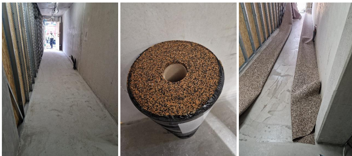
Figur 6 Utrymningskorridor föreläggning, PureStep på rulle, primer samt utrullat material
