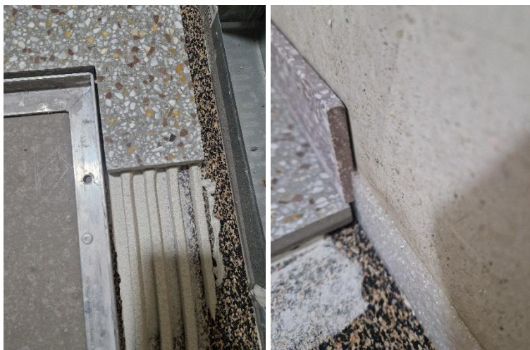
Figur 9 Avstånd till skrapmattans karm, sockel på kantband och avstånd till terrazzo
