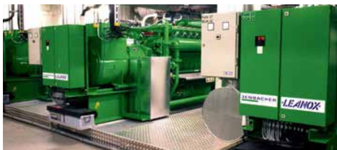
Bild 1: Elastisk uppställning av ett luftkonditioneringssystem
