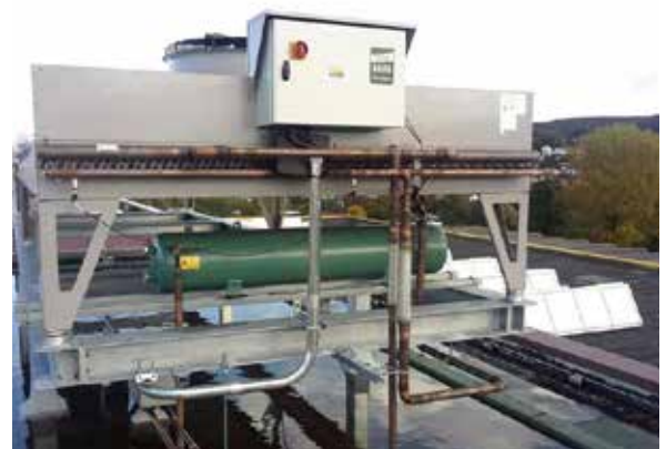
Bild 2: Strukturellt stark uppställning av ett kyltorn med hjälp av Isotop DZE
