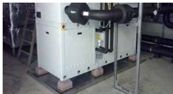
Bild 3: Uppställning av en kylare med hjälp av Sylomer®
