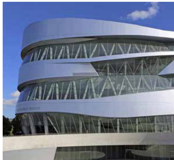
Uppställning av luftkonditioneringsystem i Mercedes Museum i Stuttgart
