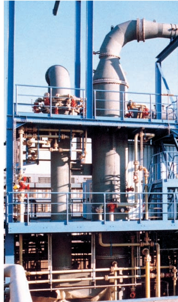
Strahlgaswäscher als Dachdüsen- quenche zur Kühlung eines heißen Rauchgases
