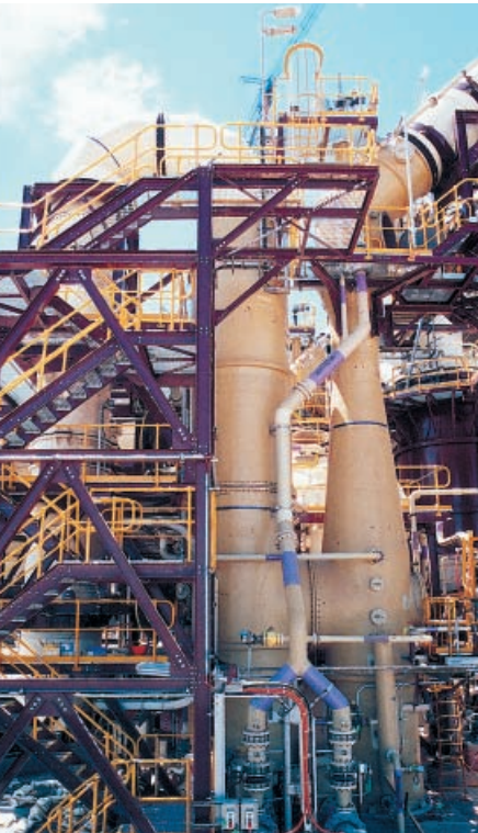
Staubabscheidung in der Kupferindustrie, Venturiwäscher für 110000 m 3 /h
