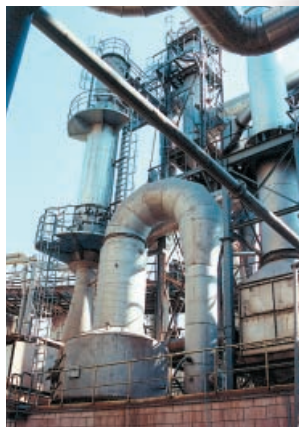
Staubabscheidung in der Holzindustrie, Venturiwäscher für 90000 m 3 /h
