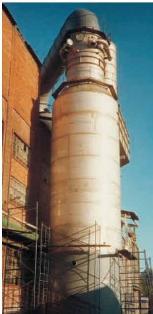
Staubabscheidung in der Zuckerindustrie, Strahlgaswäscher für 280000 m 3 /h
