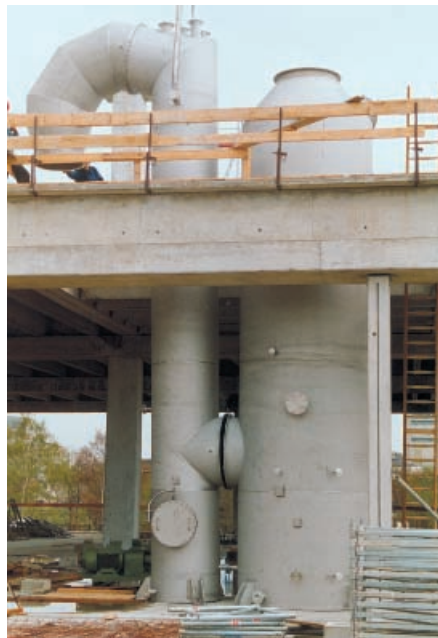
2-stufige Anlage zur Absorption von Essigsäure in der Katalysatorproduktion
