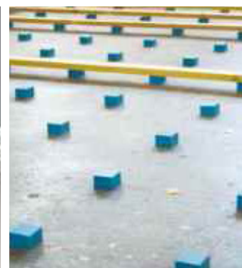
Dämpning av sportgolv: Sylodamp®-lager skyddar kroppen vid träning.
